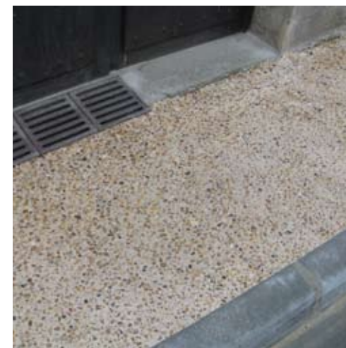
Béton désactivé alluvionnaire avec agrégats à dominante de silex
